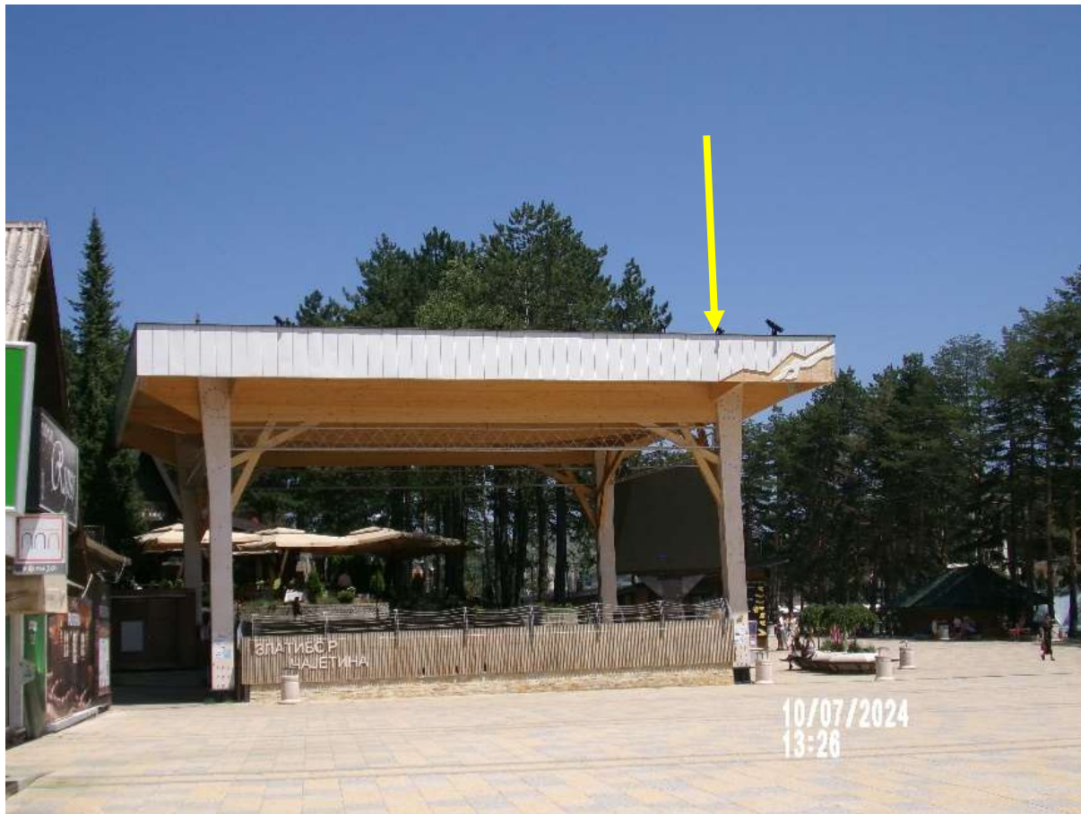
Slika 2.4 Prikaz objekta na kom se planira instalacija opreme
