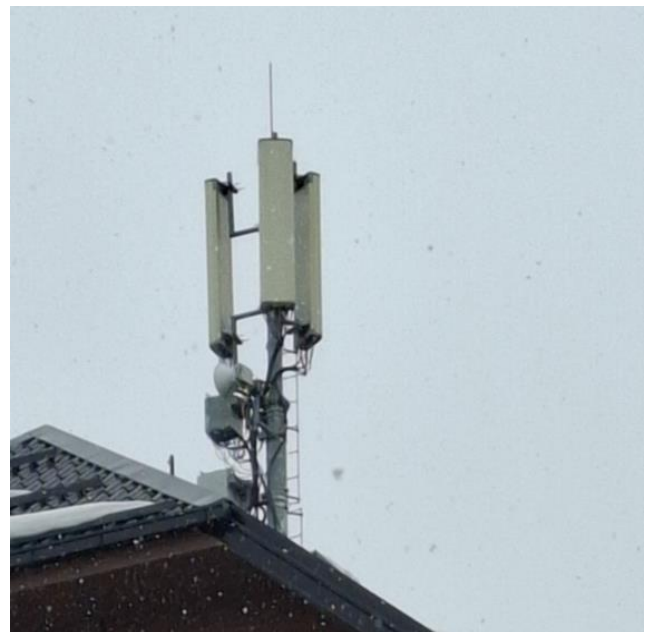
Слика 1.2. Антенски систем предметног извора (3 панел антене)
