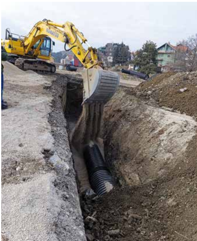
Радови на водоводној мрежи
