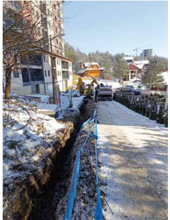
Радови на водоводној мрежи
