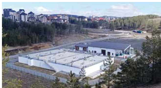
Постројење за пречишћавање отпадних вода на Златибору
