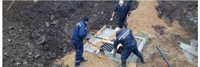
Радови на водоводној мрежи
