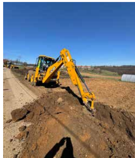
Радови на водоводној мрежи на локалитету Вишовина
