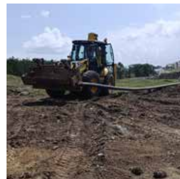
Радови на замени потисног цевовода у Широкој бари
