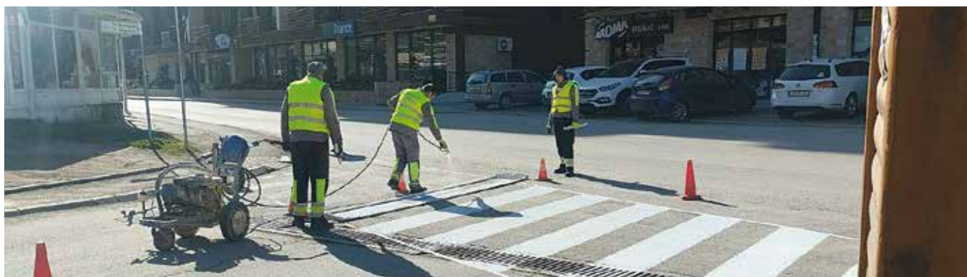
Радови на обележавању хоризонталне сигнализације
