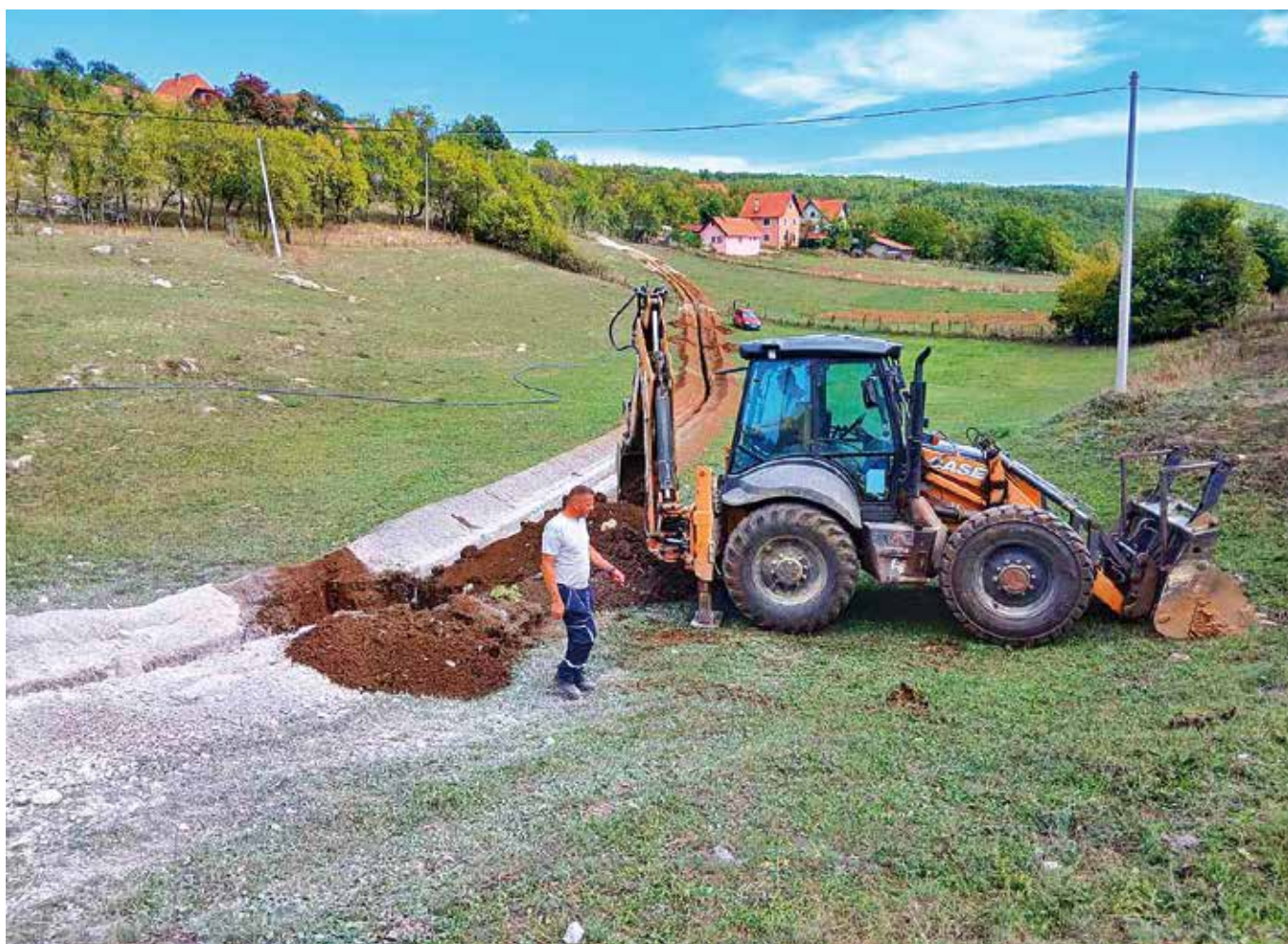
Радови на краку водовода у Шљивовици
